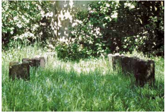
Obere Königstraße 13. Steinsockel mit Nuten für die Holzlatten der Bleichkästen (Foto: Arnold Kreisel, 2000)
